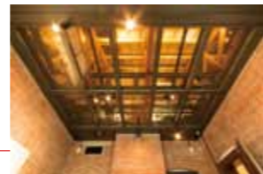
小屋裏と煉瓦壁
