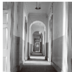
昭和期の2階南側廊下
